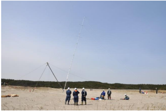
図3 風況観測ポールの建柱
