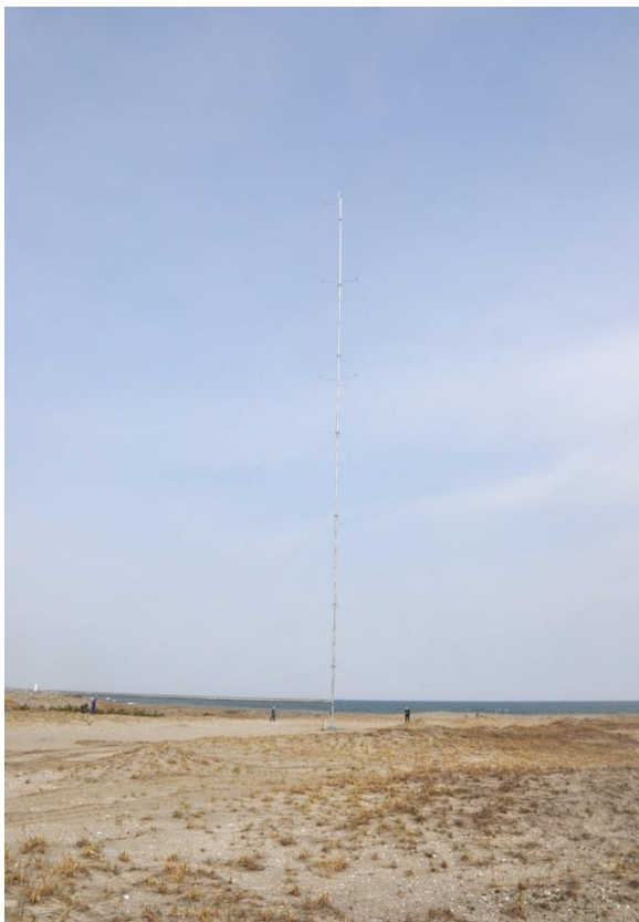
図4 建設した風況観測ポール
