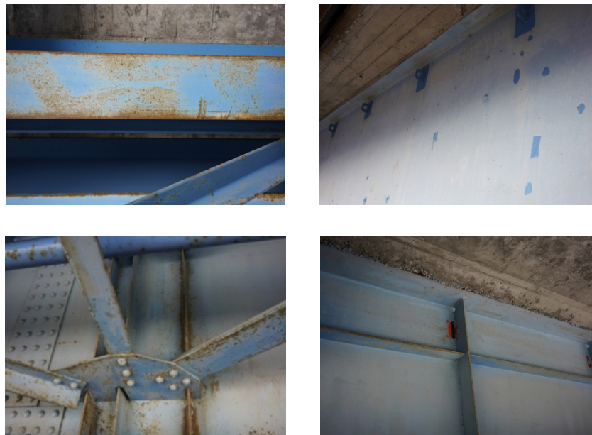
図2 テストデータ（猪苗代地区の拡幅橋）
